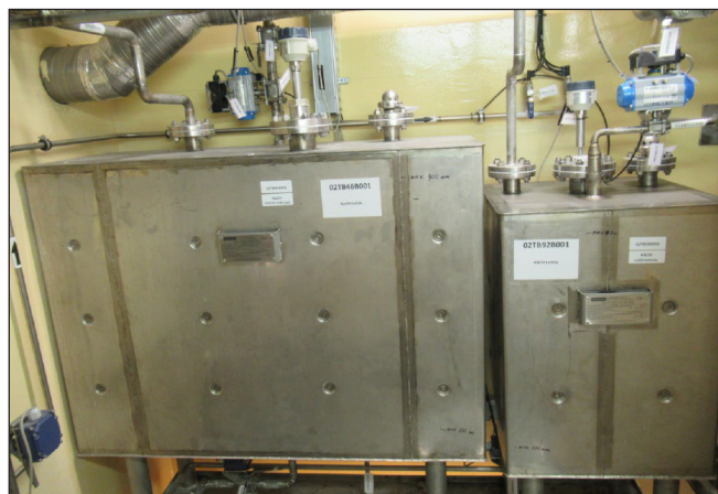
2. ábra: A technológiai lúgtartály (balra) és salétromsav tartály (jobbra)
